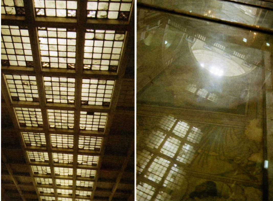
Anlamsız güneşiği tutkusunun sonuçları: * Bakımı zor tepe ışıklığı, zamanla kirlenip kötü bir görüntü oluşturmuş. * Cam yüzeylerde kaçınılmaz aynalaşmalara neden olarak çok önemli eski bir halının görülmesini tümüyle engellemiş. (Mısır Müzesi – Kahire)
